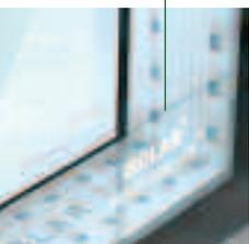
Nos vidros duplos ISOLAR NEUTRALUX® o lado tratado deve ser colocado no vidro interior e orientado para o interior da câmara (lado 3).
